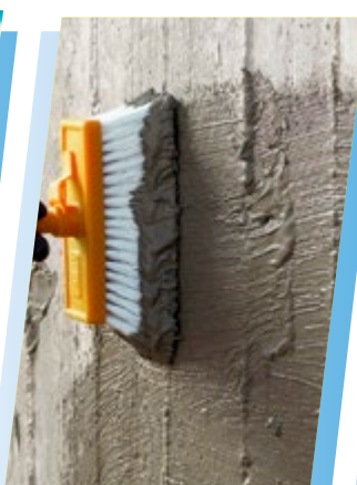
для изоляции фундамента
